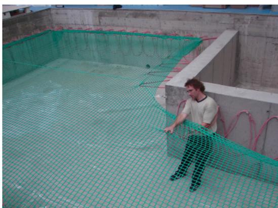
Red de sostenimiento sintética sin nudos y de una sola pieza con la superficie del foso, que se instala a unos 50 cms. de la superficie del suelo del gimnasio, mediante gomas independientes que van unidas mediante ganchos de fijación. Estos ganchos se instalan en el hormigón repartidos por todo el perímetro del foso cada 40 cms., permitiendo un enganche seguro de las gomas.
