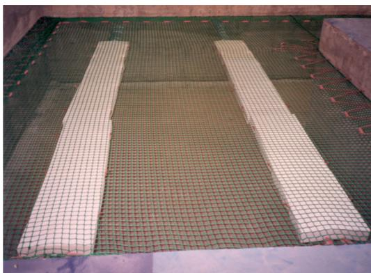
En zonas amplias del foso como en las diagonales, se instalan gomas y cinchas de nylon y tensores que evitan los hundimientos del conjunto de sostenimiento de los tacos.
