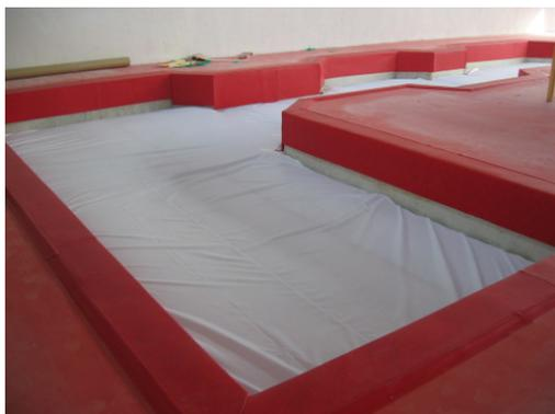
Cubierta de protección sintética de gran resistencia y de una sola pieza que abarca toda la superficie de las colchonetas que van colocadas encima de la red, y que se fija en todo su perímetro también con gomas a los ganchos instalados, para mantener la elasticidad del conjunto y evitando así zonas duras.
