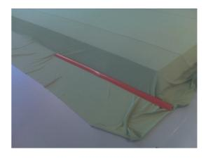
Acabado con perfil de PVC para sujeción de la tela de jersey. Se abrocha para facilitar el desmontaje y la tensión de la tela.
